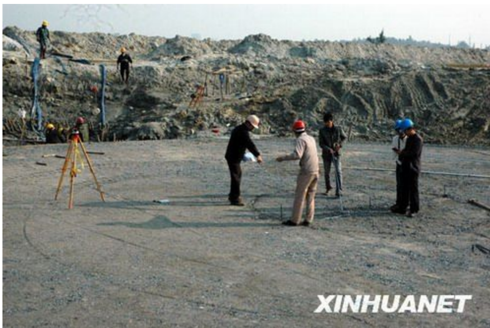
1月13日，几名技术人员正在测量场地。
