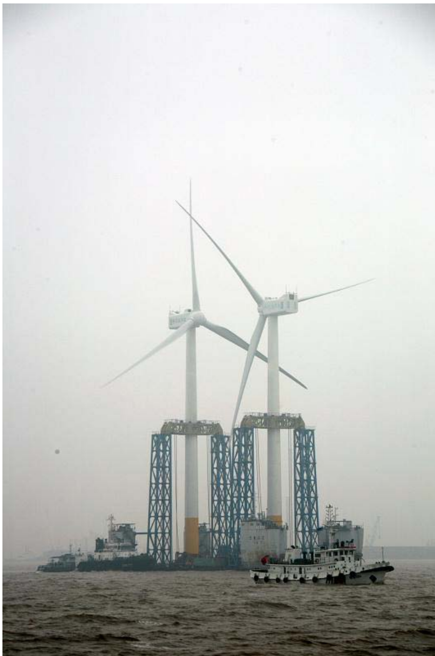
（东海风力发电两台风机一次就位）
