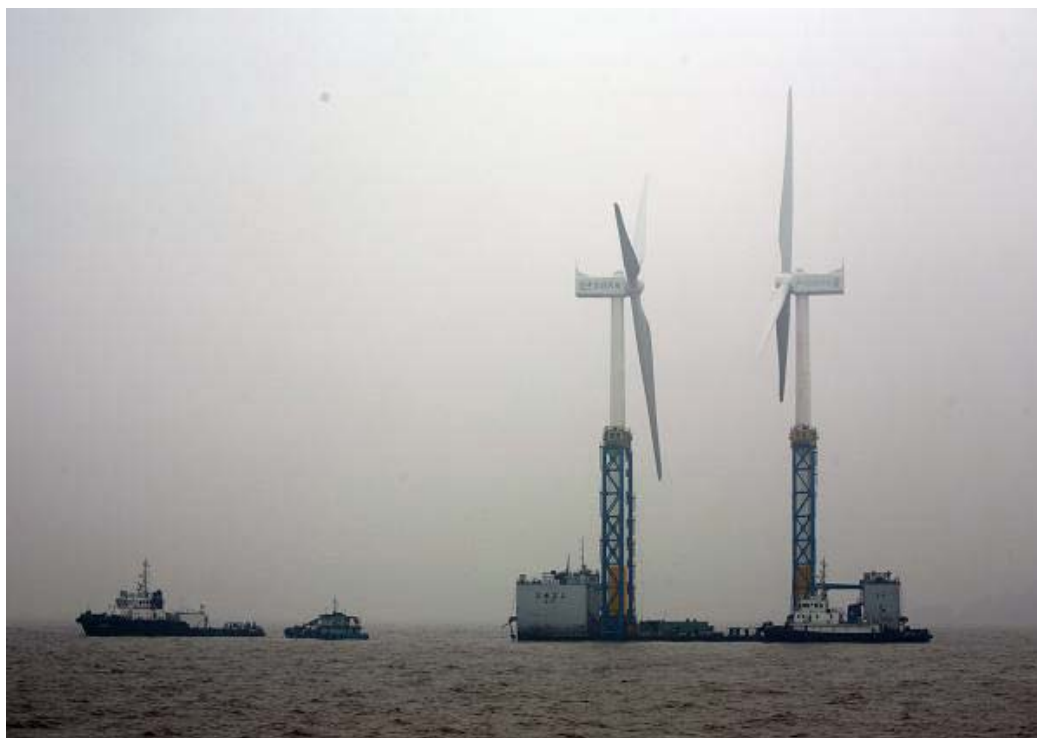
（东海风力发电两台风机一次就位）
