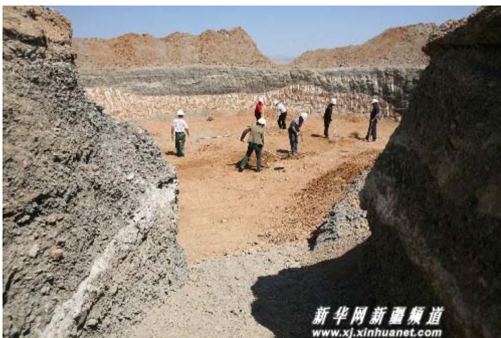
5月11日，施工人员在风电基坑内平整地面。
