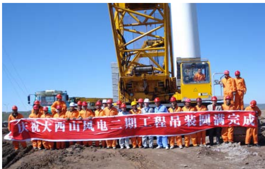
二期最后一台吊装完毕
