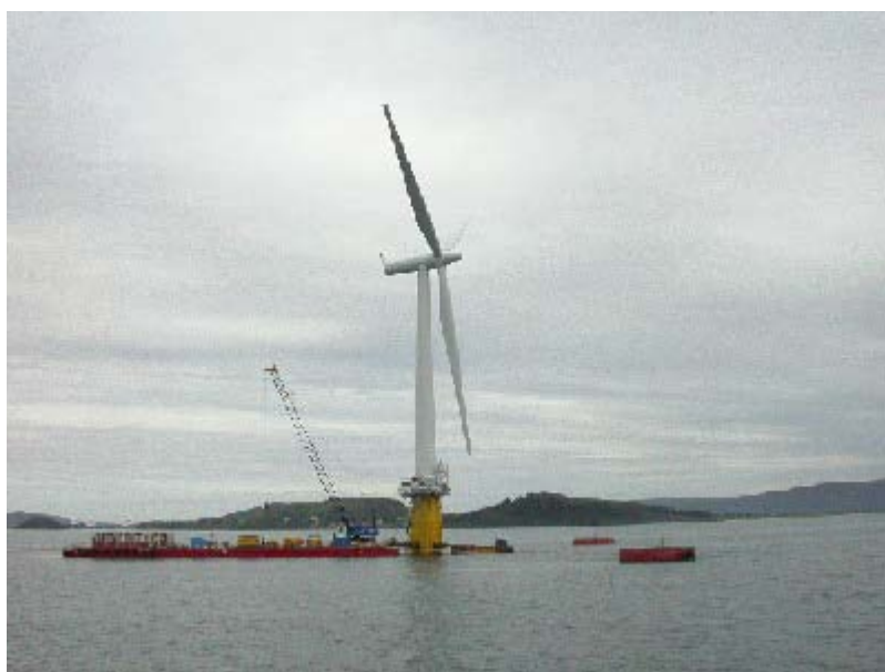
世界首座浮式风电机组 Hywind 科技日报记者华凌摄
