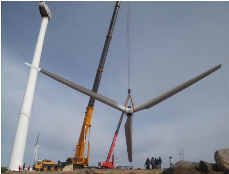
公司竹质800千瓦叶片吊装现场
