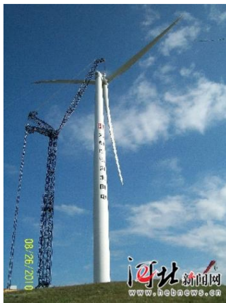
图为河北电建一公司正在进行风机叶扇吊装
