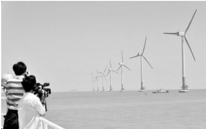
东海大桥10万千瓦海上风电示范项目。
