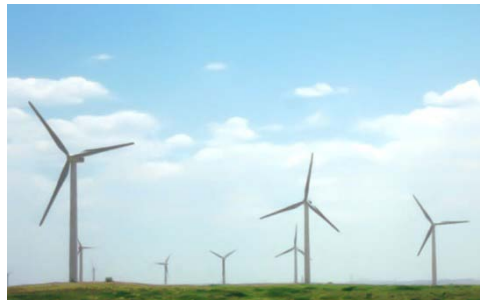
上图为装有南高齿 FD1660F 型 1.5MW 风电齿轮箱的风力发电机组在内蒙古乌拉特风场
