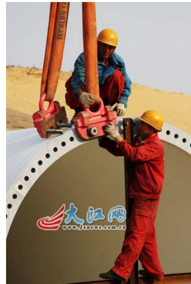
都昌老爷庙风电场项目施工人员进行风杆吊装
