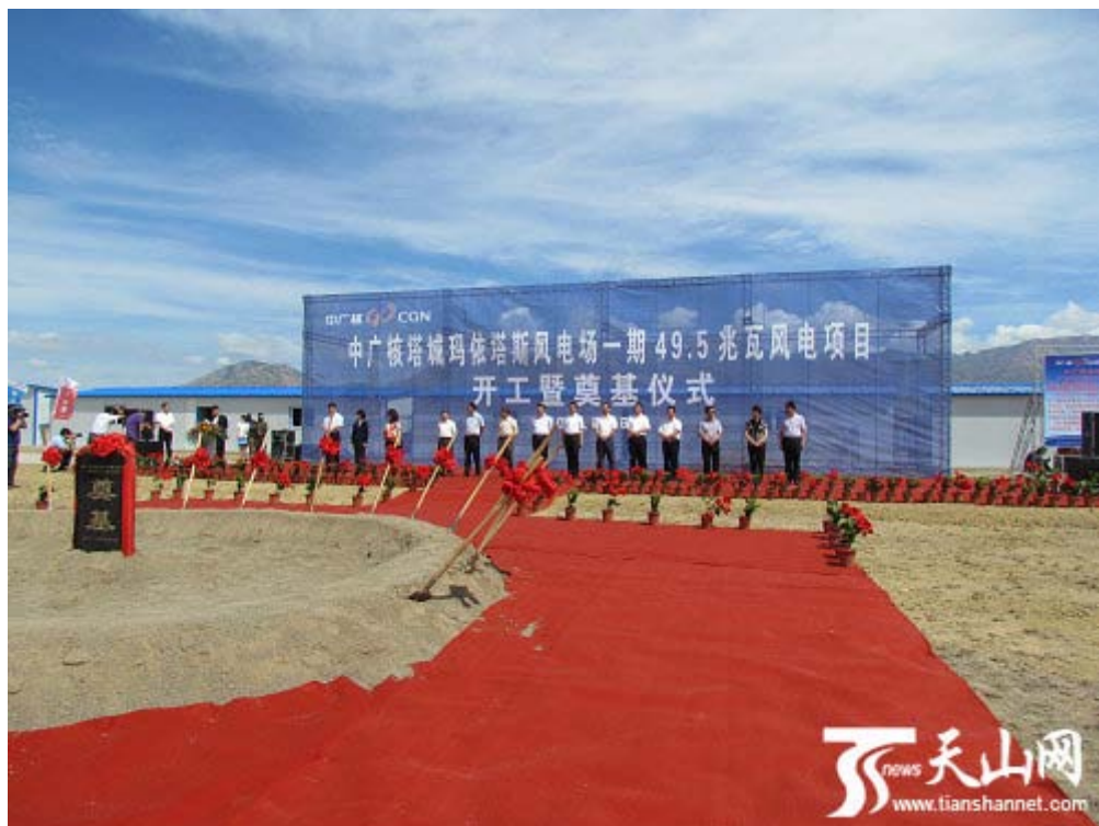
6 月 16 日，中广核塔城玛依塔斯风电场一期项目在额敏县举行开工奠基仪式。
