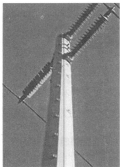
图 2 SE-28 级全复合材料电线杆
