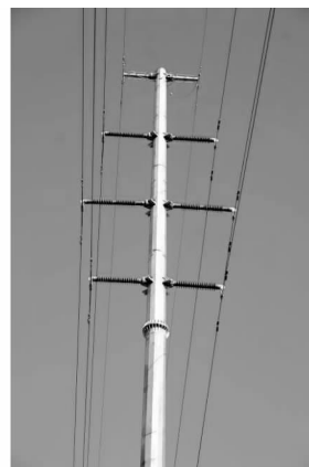
图 8 复合材料绝缘横担应用
