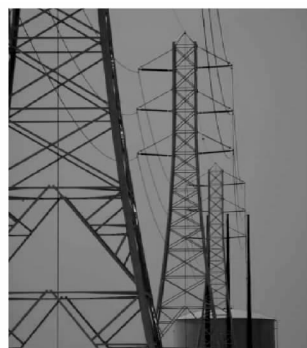
图7 美国220kV复合材料格构式输电塔
