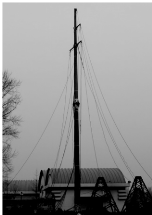
2 正常运行工况挠曲变形
