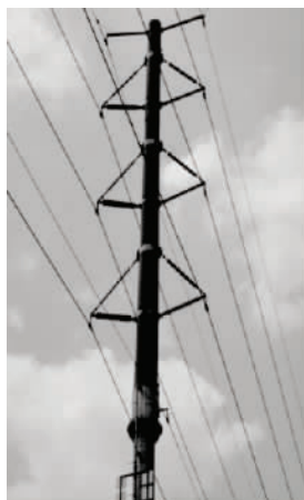
图4 深圳RS产110 kV单杆双回路组合式杆塔
