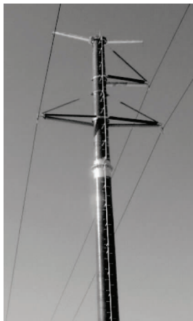
图7 220 kV 全复合材料杆塔
