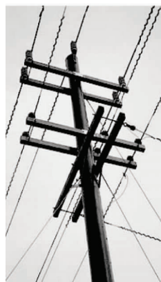
图 1 Shakespeare 公司配电杆塔
