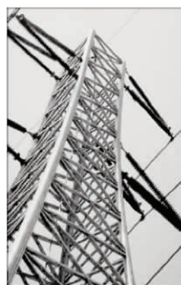
图 3 Ebert 公司组合式复合塔架
